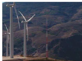
Mediciones de verificación de garantías.
