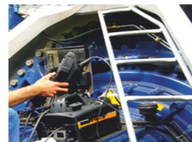
Inspecciones de aerogeneradores.
